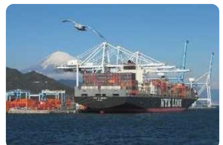
色彩計画に基づき配色されたコンテナクレーン
