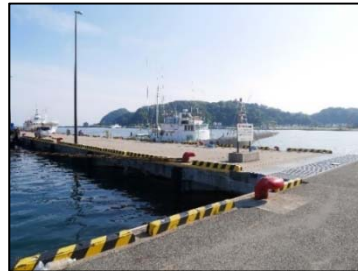
① Sotogaoka Wharf (1)
