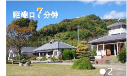
⑨三圣苑公路服务站 距港口7分钟 车位:普通84个 大型5个 餐位:45个 可享受当地特产及温泉的公路服务区。
