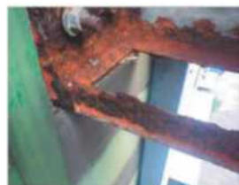
底部が腐食していた看板の例
