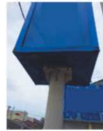
支柱・広告板接合部
