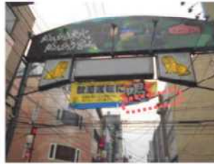
幕材を張る部材が破損した 状態
