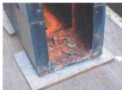
底部が腐食していた看板の例
