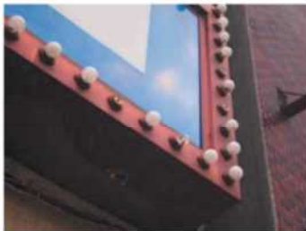
照明の不点灯
