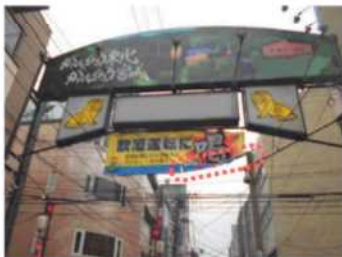
幕材を張る部材が破損した状態
