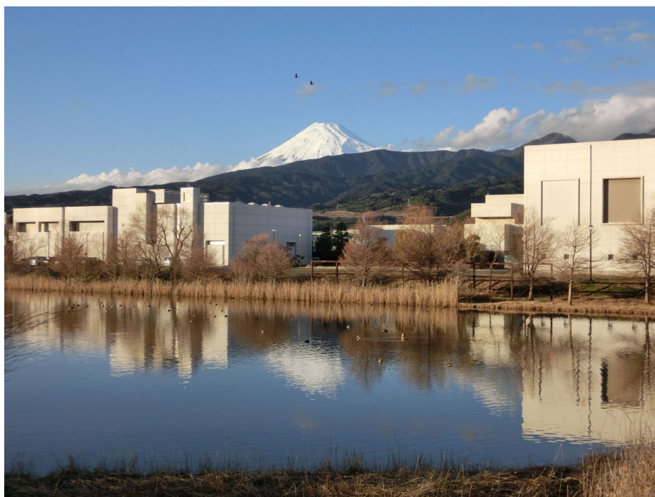
狩野川西部浄化センター （沼津市原字女鹿塚）
