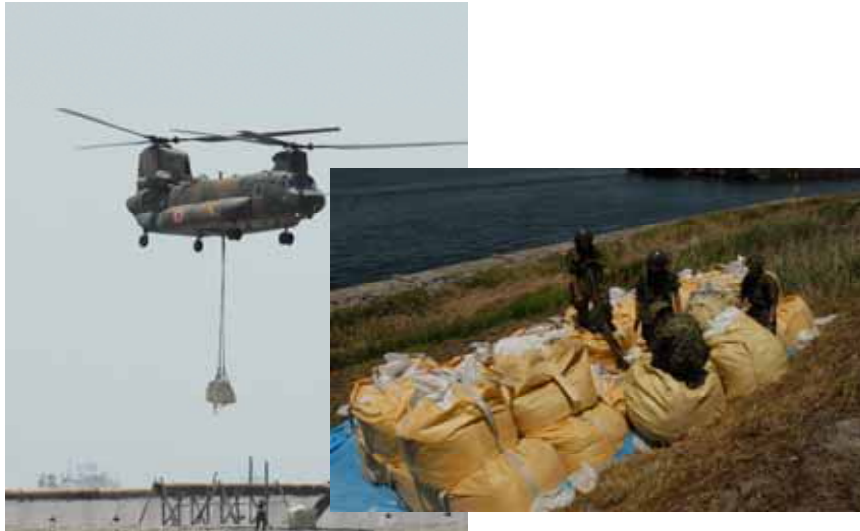
自衛隊大型ヘリによる大型土嚢を用いた堤防の緊急応急復旧訓練
