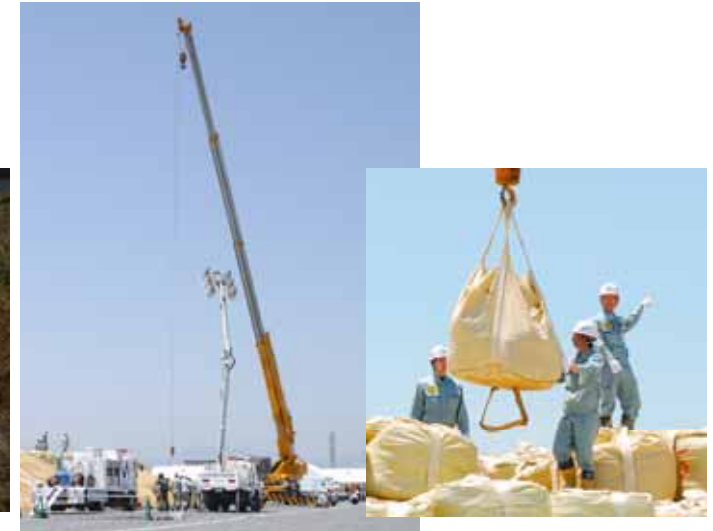
クレーン車による大型土嚢を用いた堤防の緊急応急復旧訓練
