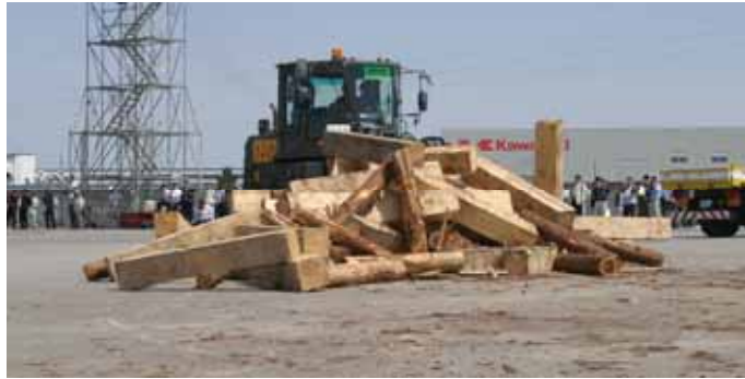
陸上自衛隊による道路啓開作業
