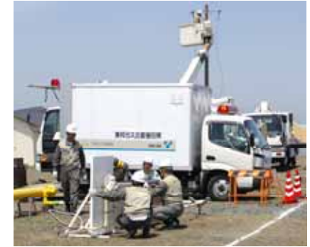
ライフラインの復旧作業
