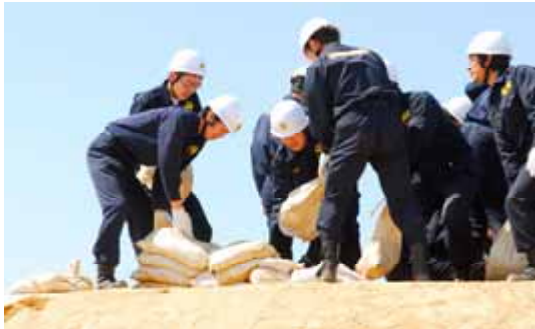
弥富市・飛島村の消防団は、模範堤防において積み土の工を実施
