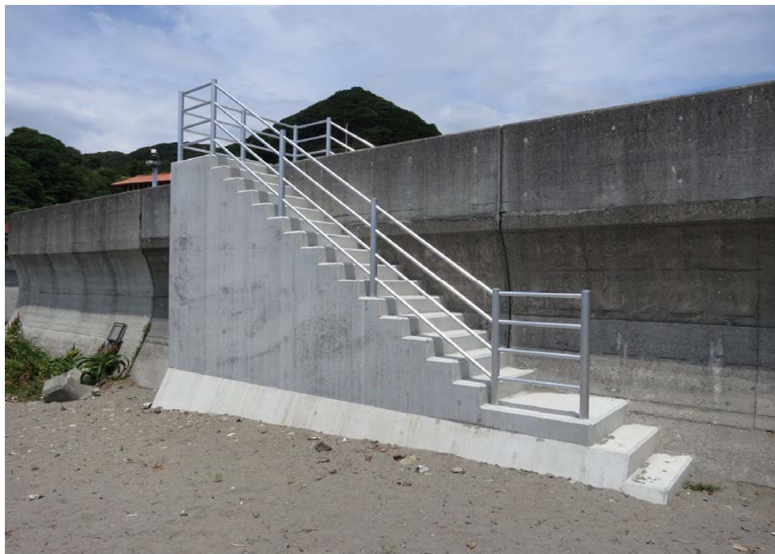
「妻良漁港（南伊豆町）・防潮堤階段工 海側」
