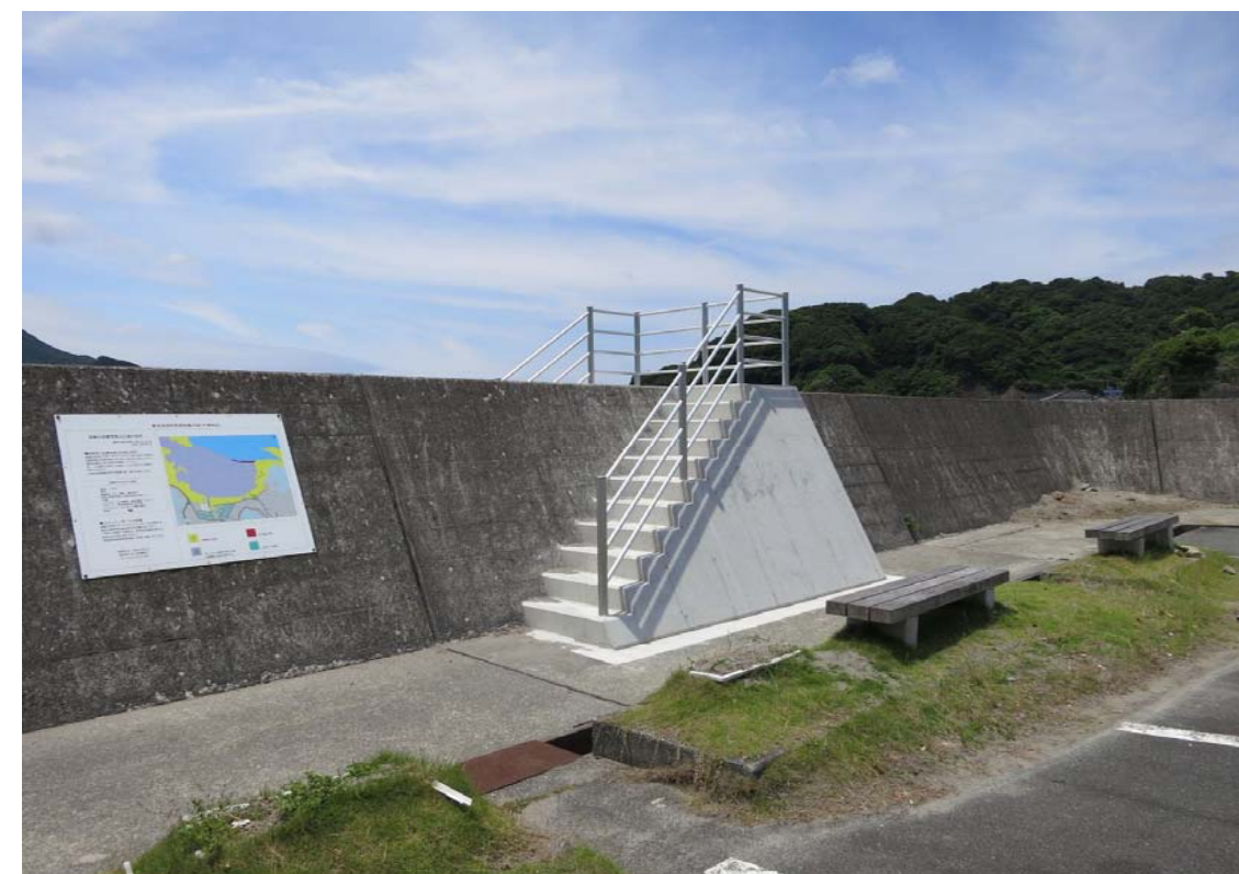
「妻良漁港（南伊豆町）・防潮堤階段工 内陸側」
