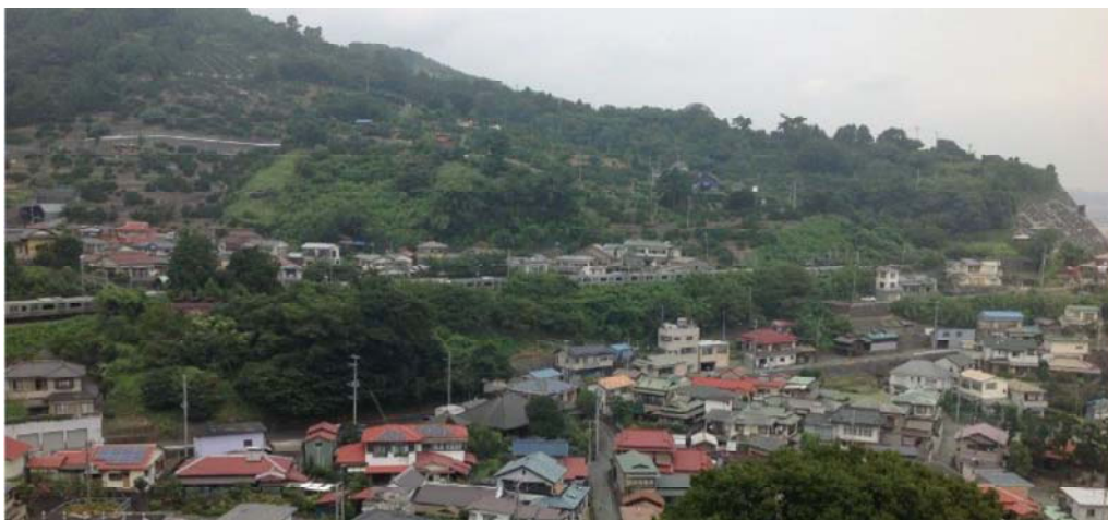
図 10. 鉄道盛土でせき止められた米神沢の土石流（鉄道省， 国有鉄道震災記）：下の写真は異なる角度で米神沢を俯瞰した様子。鉄道盛土の山側に土石がせき止められた。
