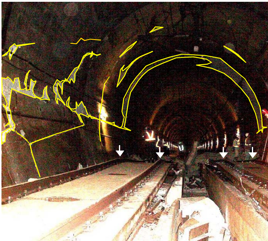
図5 魚沼トンネルの被害箇所 a_1 ( 37.2833^{\circ}\text{N} , 138.86579^{\circ}\text{E} ), 東京側入口より 195,050m. トンネルを斜めに輪切りにするようなクラックパターンが現れている (写真: 小長井, Jhansson et al [9]より)
