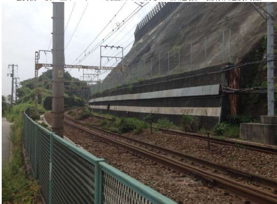
現在の根ノ上トンネル跡 (擁壁に転用されている。撮影 小長井)
