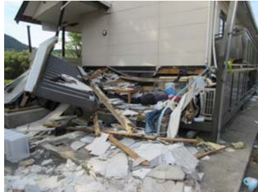
写真. 学生アパート（木造2FL：1階が層崩壊）
