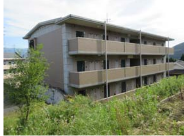
写真. メゾンM（RC造4FL：外観は無損傷。そで壁にひび割れ発生なし。
