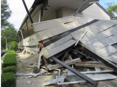
写真. 学生アパート（木造2FL：1階が層崩壊）
