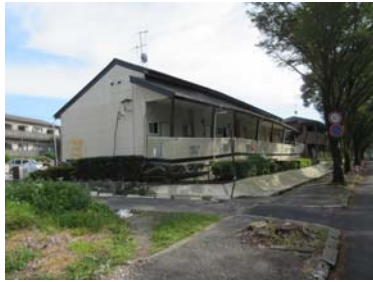
写真. 学生アパート（木造2FL：1階が層崩壊）
