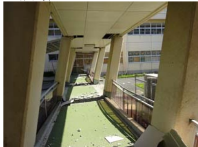
写真. 益城町K中学校渡り廊下：補強済み（堀江建築工学研究所・太田勤、太田宏氏提供：5月1日撮影）。
