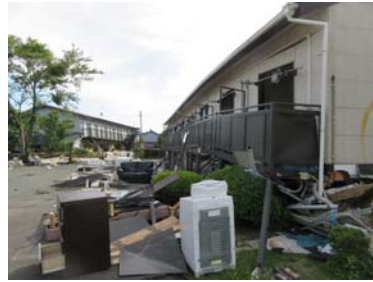
写真. 学生アパート（木造2FL：1階が層崩壊）
