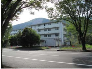
写真. B学塾（RC造4FL：傾斜大で崩壊危険で使用禁止。周辺地盤に変状。）
