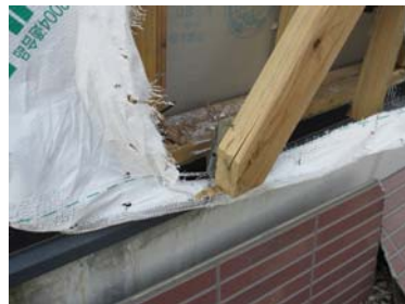
2016年熊本地震被害調査報告書 写真. 学生アパート（木造2FL：筋交い端部が抜け出し） May 30, 2016
