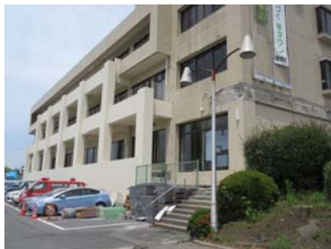
写真. 益城町庁舎:外付フレーム補強.
