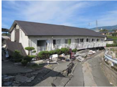
2016年熊本地震被害調査報告書 写真. 学生アパート（木造2FL）、建物前面&背面（鉄骨階段） May 30, 2016
