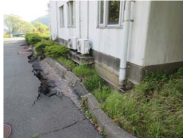
写真. B学塾（RC造4FL：傾斜大で崩壊危険で使用禁止。周辺地盤に変状。）
