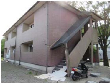
2016年熊本地震被害調査報告書 写真. 学生アパート（木造2FL：筋交い端部が抜け出し） May 30, 2016
