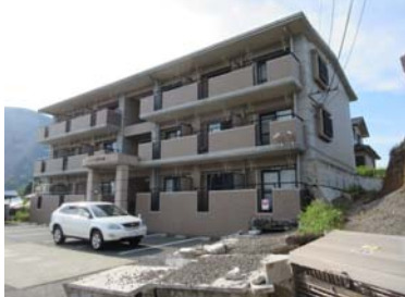
写真. メゾンM（RC造4FL：外観は無損傷。そで壁にひび割れ発生なし。
