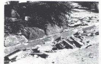
伊豆東方群発地震で屋根瓦が落下 飛散 (川原町・葛城正平さん宅)
