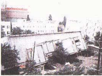
液状現象による傾倒したビル
