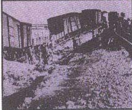
軟弱地盤地帯で被害をうけた鉄道（1944年東南海地震M7.9袋井-磐田間）
