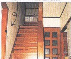
リフォームにより壁にした所
