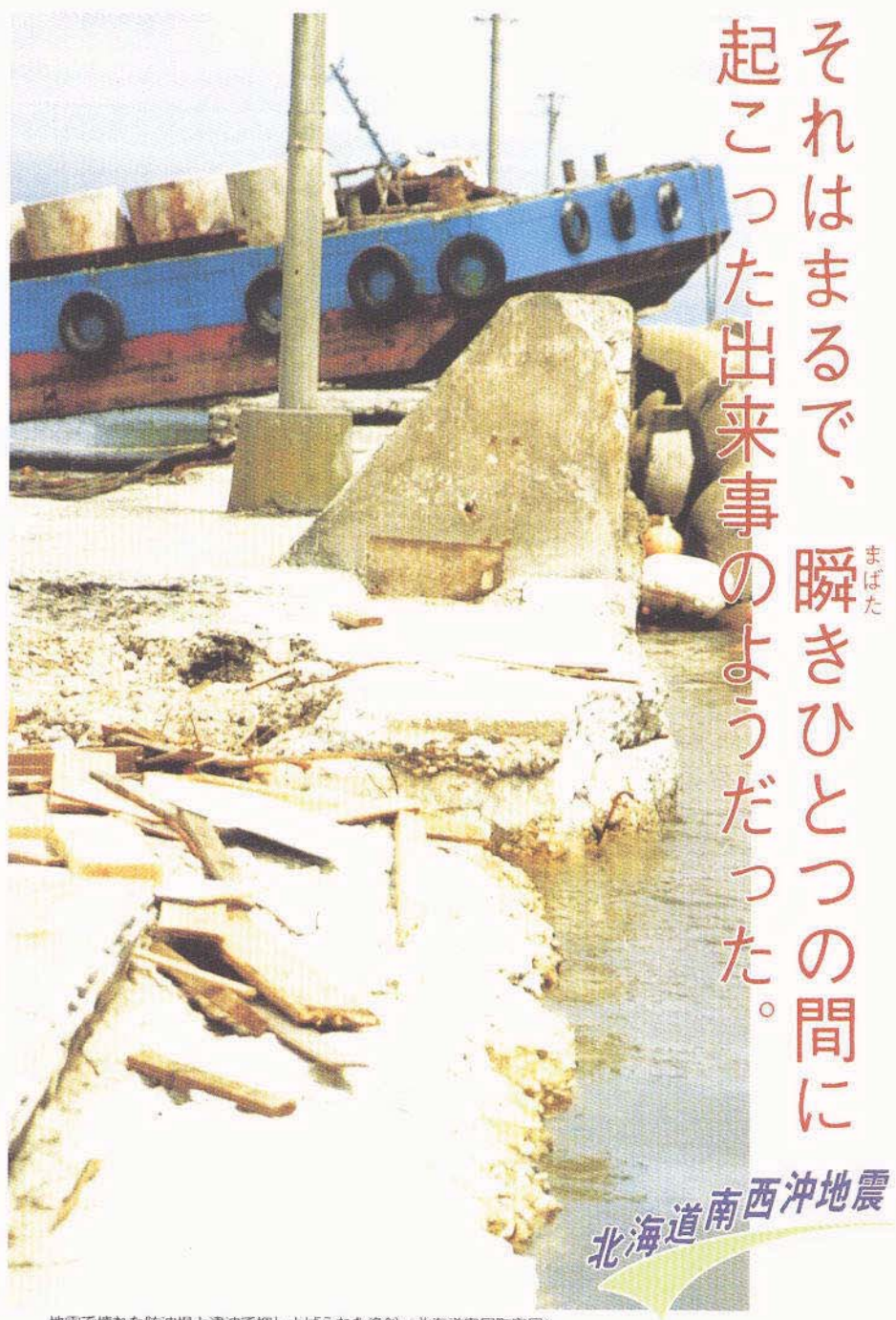
地震で壊れた防波堤と津波で押し上げられた漁船 (北海道奥尻町奥尻)
