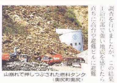
山崩れで押しつぶされた燃料タンク (奥尻町奥尻)
