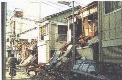
これまでの地震では見られなかった倒れ方の家(上)、中央の家は持ちこたえた(中)、筋かいが露出した建物(下)
