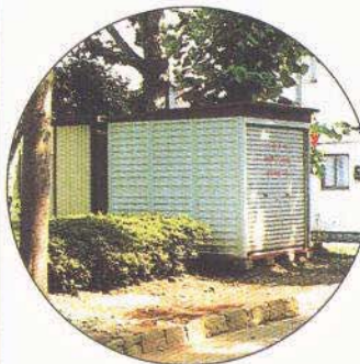
⑩防火水槽と防災ポンプ置場
