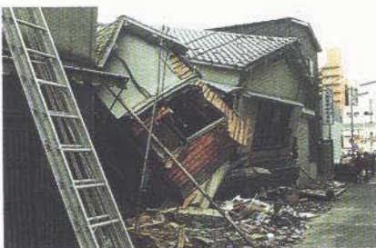
これまでの地震では見られなかった倒れ方の家(上)、中央の家は持ちこたえた(中)、筋かいが露出した建物(下)
