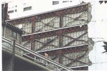
これまでの地震では見られなかった倒れ方の家(上)、中央の家は持ちこたえた(中)、筋かいが露出した建物(下)
