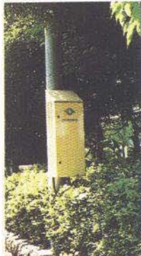
⑧特設公衆電話機 災害に備え避難地の公園などに設置されています。県内では約1,100カ所、3,000台。
