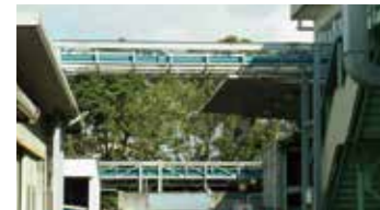
災害復旧や二次災害防止できる、「見える化」した屋外配管類
