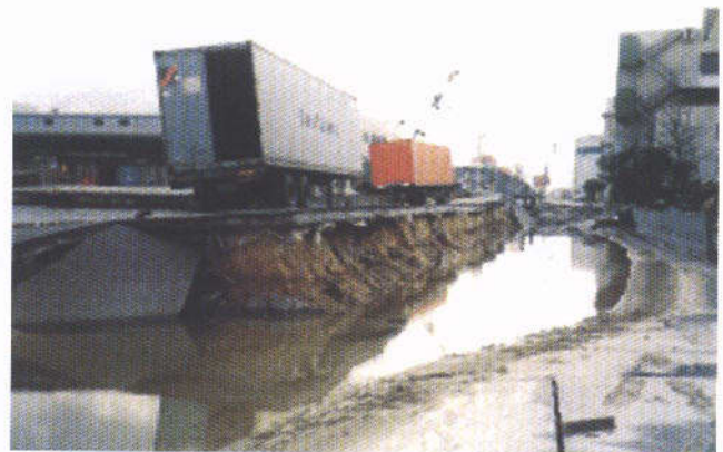
写真5 平成7年(1995年)兵庫県南部地震による埋立地の地盤沈下
