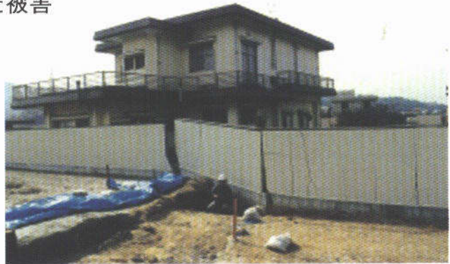
写真1 兵庫県南部地震による被害（撮影 柳田誠）
