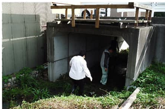
避難状況（蓬萊橋付近ボックスカルバート）
