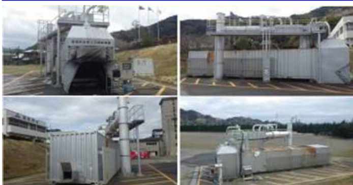
濃煙熱気実火災訓練施設
