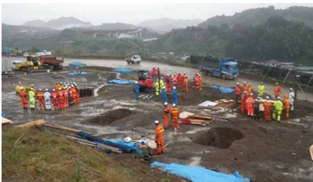
土砂災害対応救助(静岡市消防局清水消防署)
