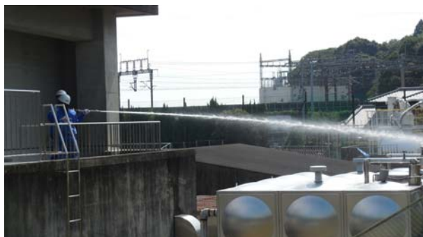
屋内消火栓による放水
