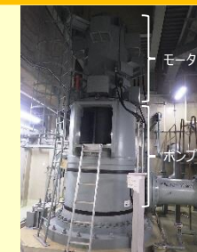
低圧注水設備(モータ駆動)
