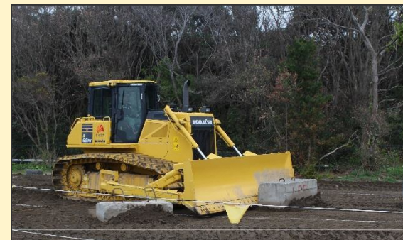
瓦礫撤去訓練
