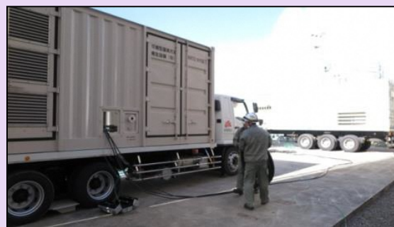
窒素供給車両操作訓練
