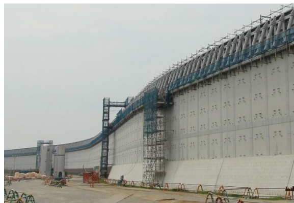
防波壁設置状況 (発電所側より)
