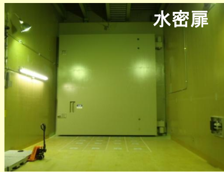
原子炉建屋大物搬入口 (内部)水密扉設置状況
