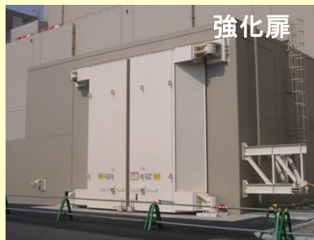
原子炉建屋大物搬入口 (外側)強化扉設置状況
