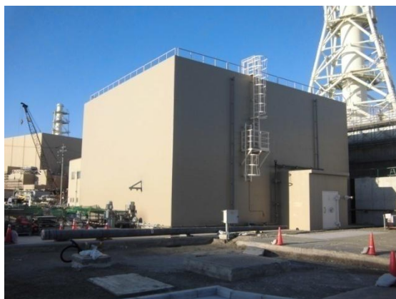
緊急時海水取水ポンプ室(防水構造の建屋)
