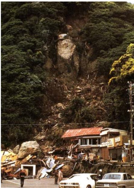
石廊崎の売店の被害 「被害から学ぶ地震工学」伯野元彦著より
