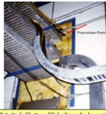
BF 1の火災の一因となったケーブル・トレイ貫通部のシール材の例
