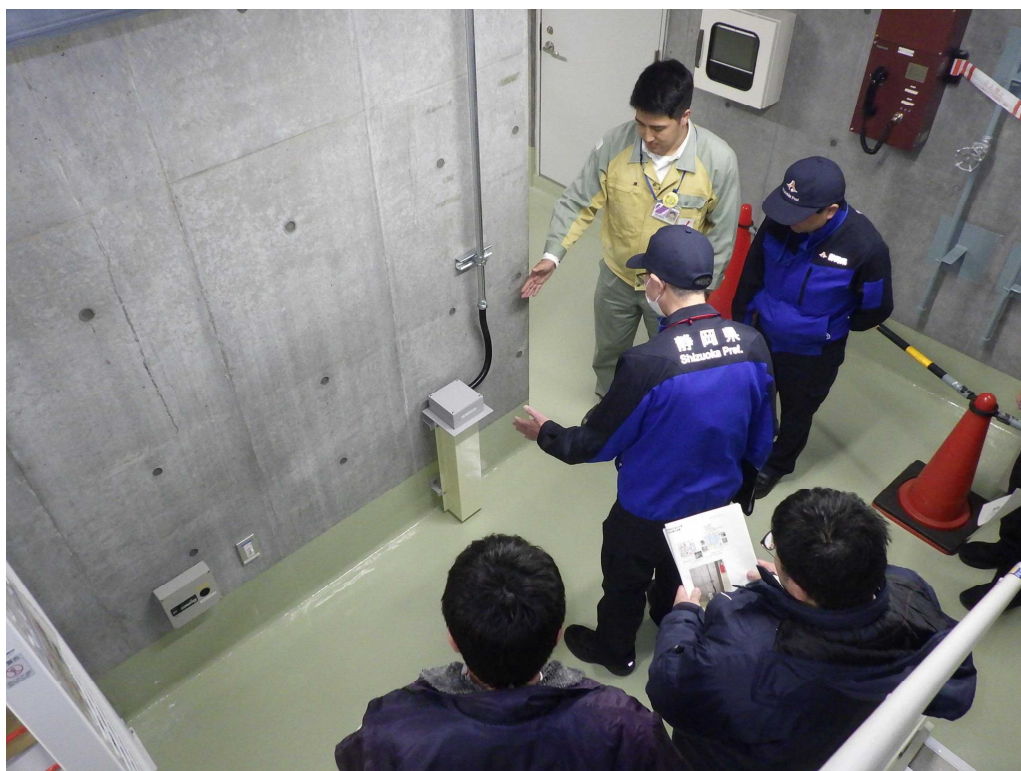
漏えい検知器の設置状況の点検の様子
