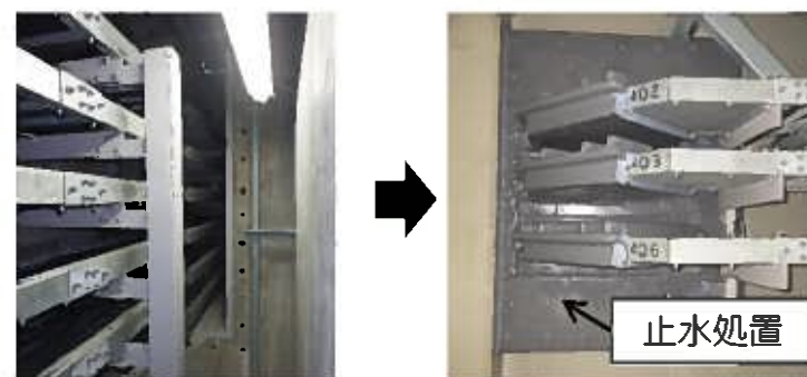
止水処置（電路）
