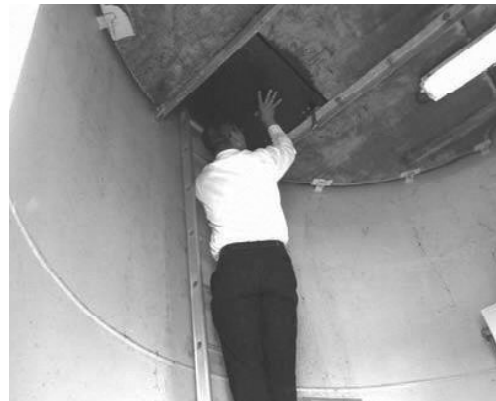
風車内部（管理用）の様子を見る筆者
