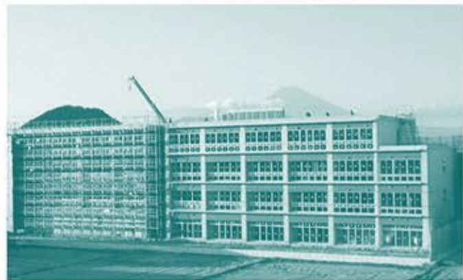
▲建設中の校舎 北側にきれいな富士山が見えます
