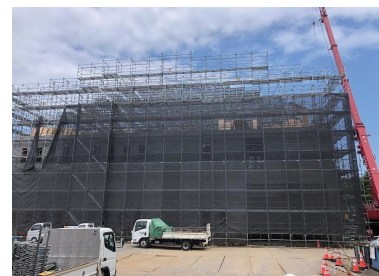
▲ 工事中の体育館
