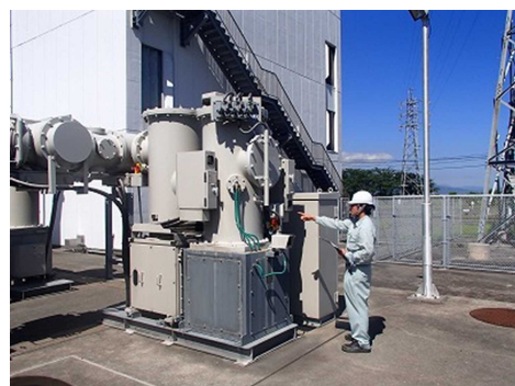
《下水道施設の設備点検》
