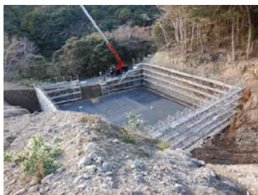
防災施設施工中
