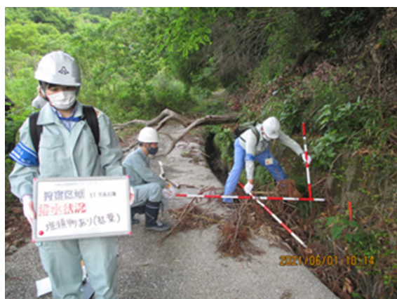
地すべり施設（排水路） 点検中
