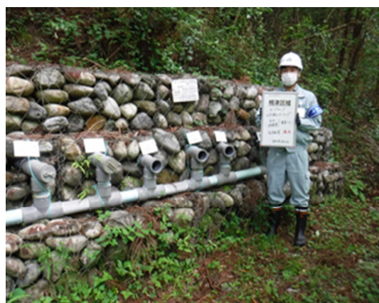
地すべり施設（横孔ボーリング）異常なし
