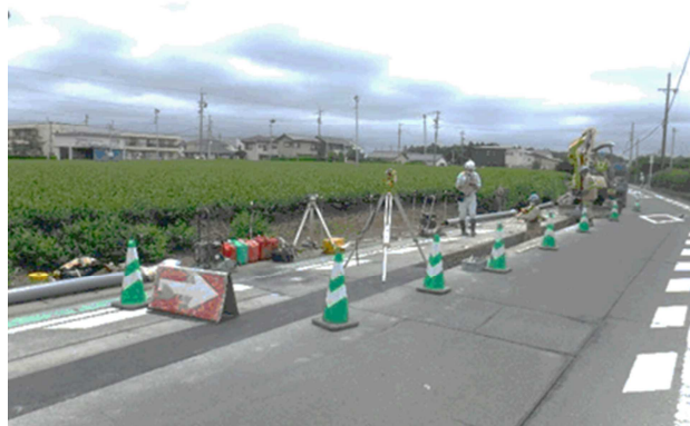
三方原用水の山の神支線を更新中
