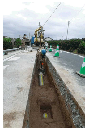
老朽化した管を交換
