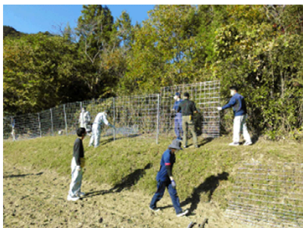
設置作業風景①(高低差あり)
