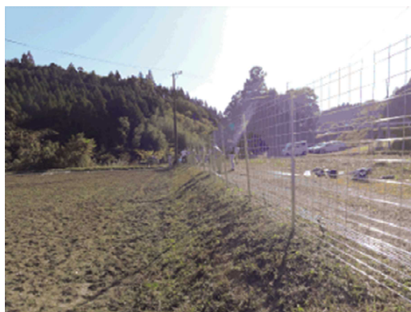
設置作業風景②(土が硬く杭打ちに苦戦)
