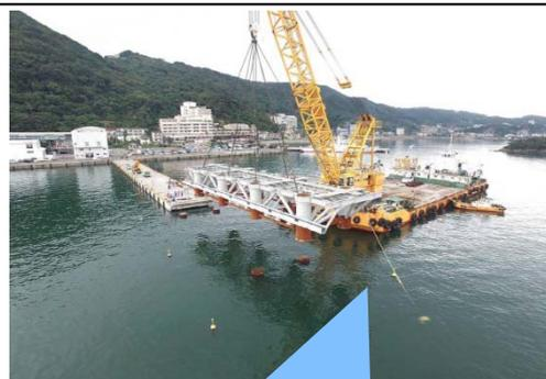
現在、棧橋の桁となるブロックの据付けを行っています。
