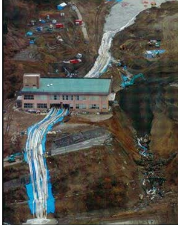
天然ダムポンプ排水
