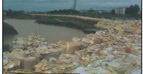
堤防決壊部応急仮締切
