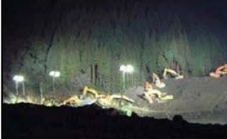
照明車による照明
