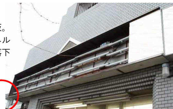
←パネルの変形、ズレ、破損の他、パネルの押さえ枠が変形し落下する場合も。
