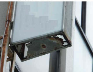
↑看板底部の留め具が壊れるとアクリル板が抜け落ちる原因にも。
