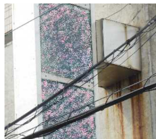
←ブラケット下に汚ダレが見られると、内部の取付金具にサビや腐食の可能性もある。
