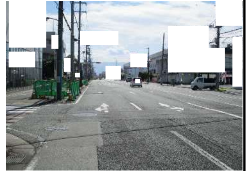
物損事故現場（全景） （看板損傷）
