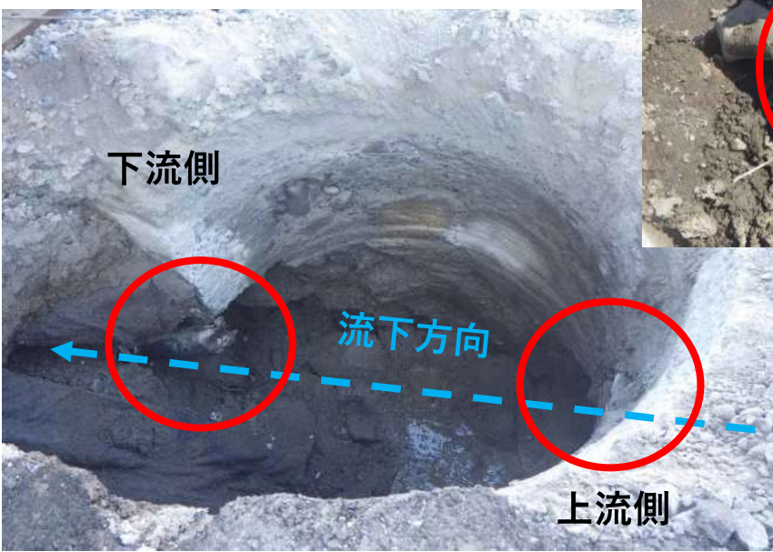
ケーシングチューブ引き抜き後
