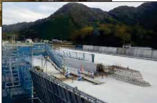
現在、工事も着々と進んできていて、架設された高架橋には、床版の打設が完了しています。今後は、舗装や側道、雨水貯留施設などの工事を行っていく予定です。
