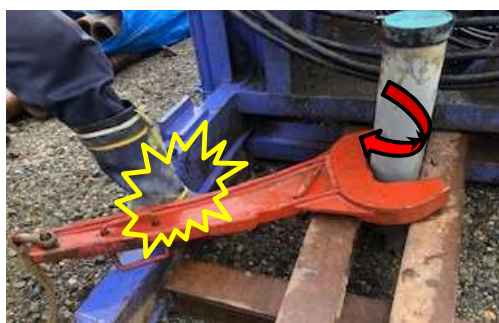
作業員被災状況（推測）
