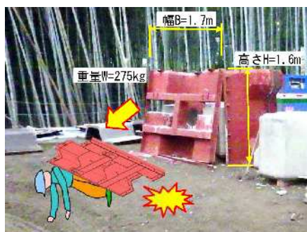
作業員被災状況（推定）
