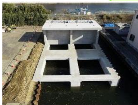
高塚ポンプ場状況 （中央土木整備事務所）
