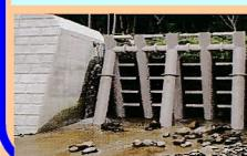
土石流が起きたときに、大きな岩や木が混ざった土砂をくい止め、下流への被害を防ぐ施設です。
