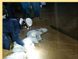
水害時の対応(土のう積み)
