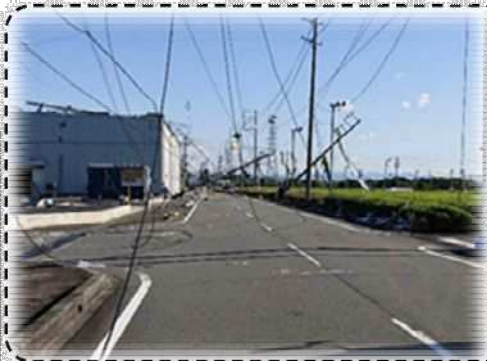
←令和3年5月1日に発生した牧之原市内の突風被害の写真です。倒れた電柱により道路が封鎖されています。
