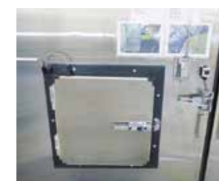
冷凍倉庫扉の脱出用小窓
