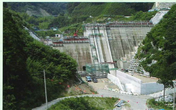
H16.7 本体コンクリート打設中
