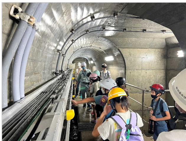
ダム堤体内見学
