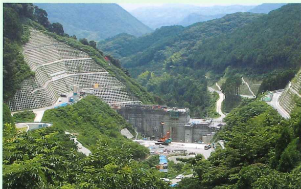
H16.7 本体コンクリート打設中
