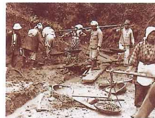
伊佐地川(浜松市西区湖東町) 昭和25年度砂防工事の実施状況
