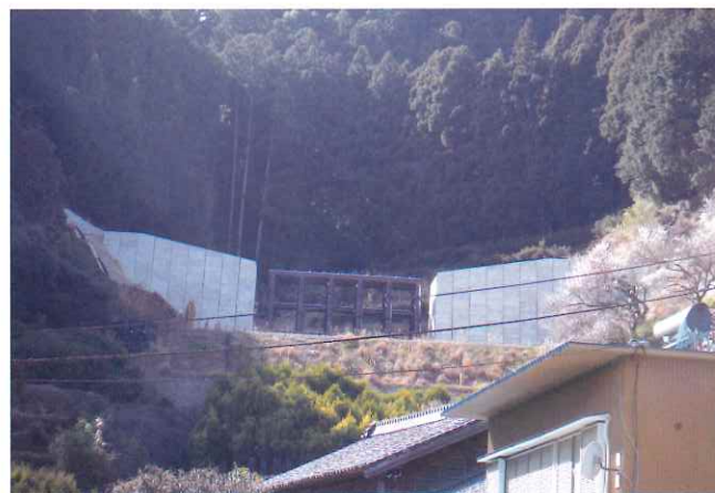
災害関連緊急砂防工事完成
