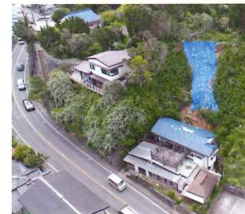
崩壊斜面の状況
