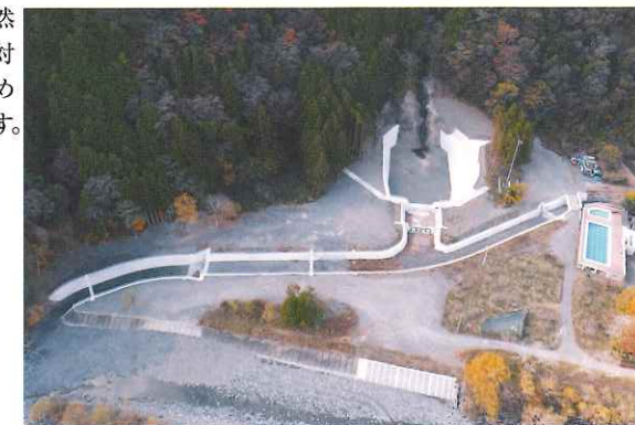
ピワミズ沢沈砂地工(R3完成)
