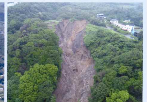
逢初川源頭部の状況
