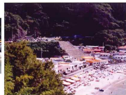
対策工事完成(危険な斜面の取り除き)
