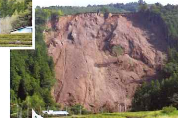
崩壊発生後斜面状況
