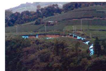
地すべり頭部の滑落崖
