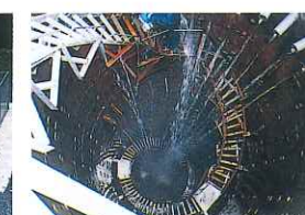
集水井内で地下水を 排除している状況
