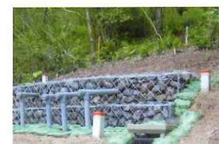
横ボーリング工
