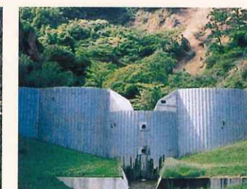
河津川水系 中山沢 (河津町湯ヶ野) 静岡県初めての鋼製セル堰堤H=12mL=49.5m (平成3年)
