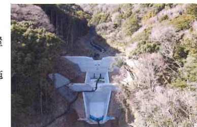
砂防堰堤の施工状況(令和5年2月27日)
