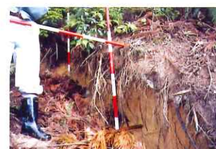
地すべり頭部の段差状況
