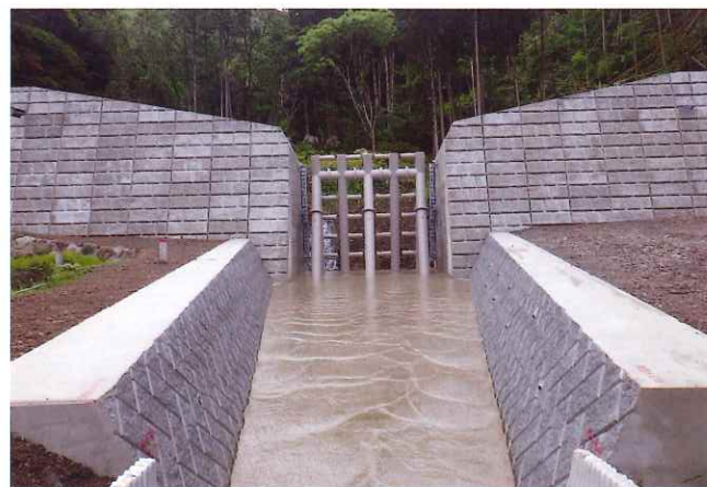
災害関連緊急砂防工事完成
