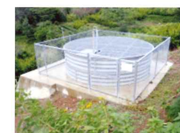
集水井工(ライナープレート)
