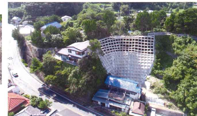
災害関連緊急急傾斜地崩壊対策工事完成
