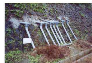
横ボーリング工
