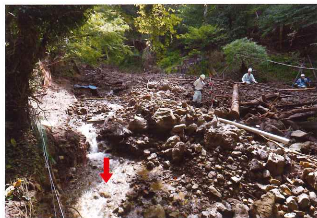
南郷北沢荒廃状況
