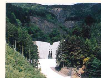
安倍川水系 亀久保沢 (静岡市葵区口坂本) 静岡県内最高の砂防堰堤H=26mL=81m (平成元年)
