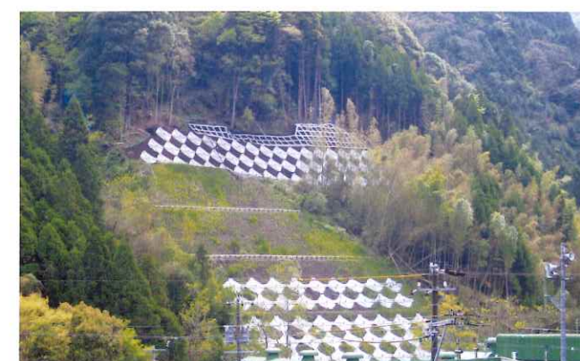
対策工事完成
