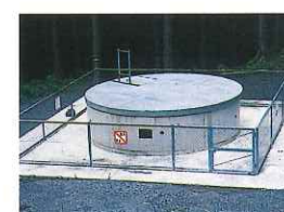
集水井工(RCセグメント)
