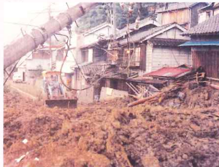
がけ崩れにより電柱や建物が損壊 (静岡市)
