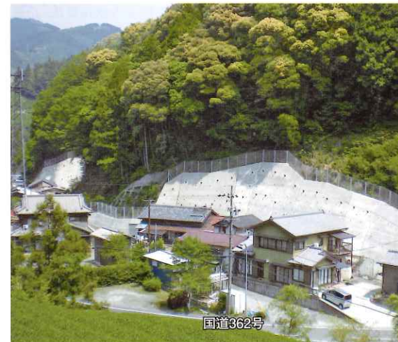
相俣向山 急傾斜地(静岡市葵区相俣)
