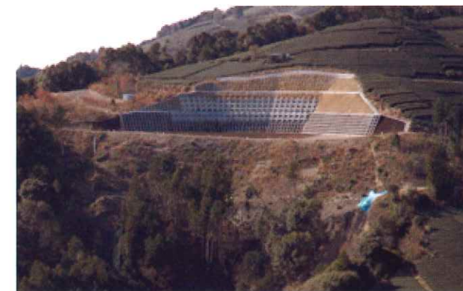
災害関連緊急地すべり対策工事完成
