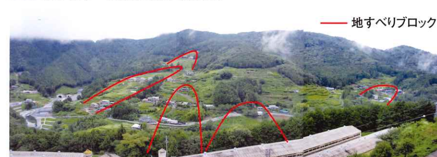
人家と優良な農地を保全する地すべり対策 寺野 地すべり(浜松市北区引佐町)
