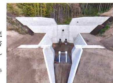
松沢川第1砂防堰堤(令和5年1月完成)
