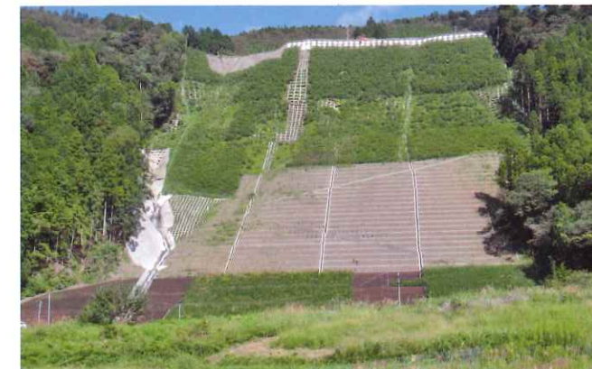
地すべり対策工事完成(H31.3)
