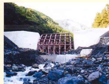
安倍川水系 坂本川 (静岡市葵区口坂本) 格子型鋼製砂防堰堤 (平成12年)
