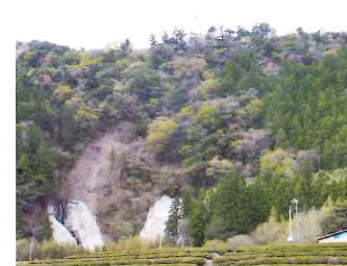
崩壊前斜面状況
