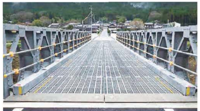
(写真：(一社)日本橋梁建設協会協会誌「虹橋No. 83」より)
