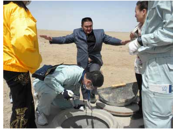
写真-7：送水管（上水）の施工状況
