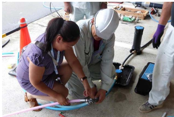
写真-2：配管工事施工管理の実務研修
